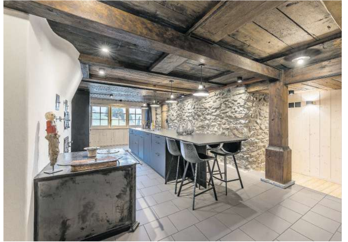
Die Stütze in der Küche stammt aus dem Historischen Bauteillager Thurgau.
